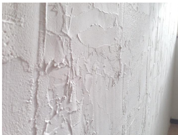
壁塗りの様子と仕上がり
